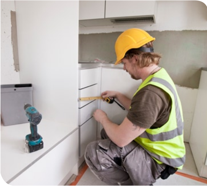
Monet asumisyksiköt ovat peruskorjauksen tarpeessa
